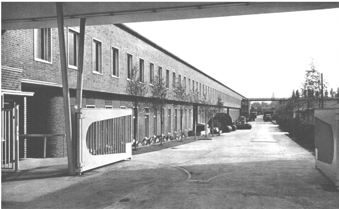
Werkseinfahrt Xantener Straße mit Förderbandhalle
